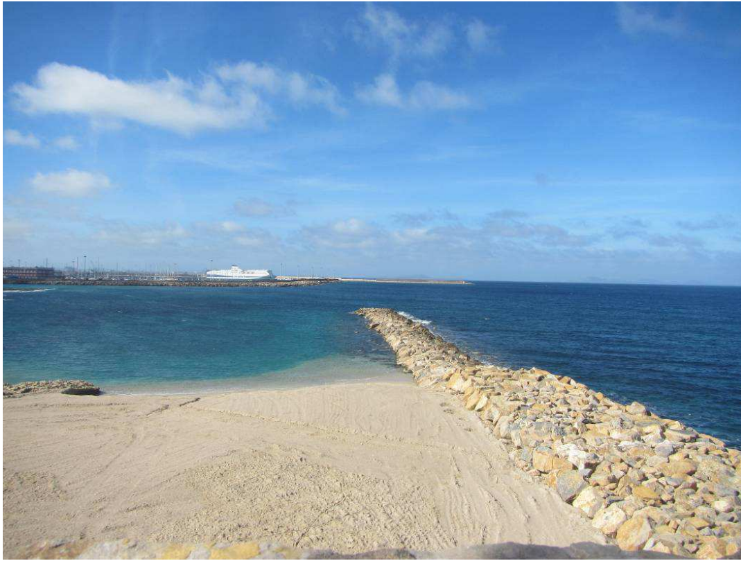
Figura 21. Il pennello artificiale e la falcata sabbiosa a seguito del ripascimento con inerti da cava nella spiaggia di Acque Dolci
