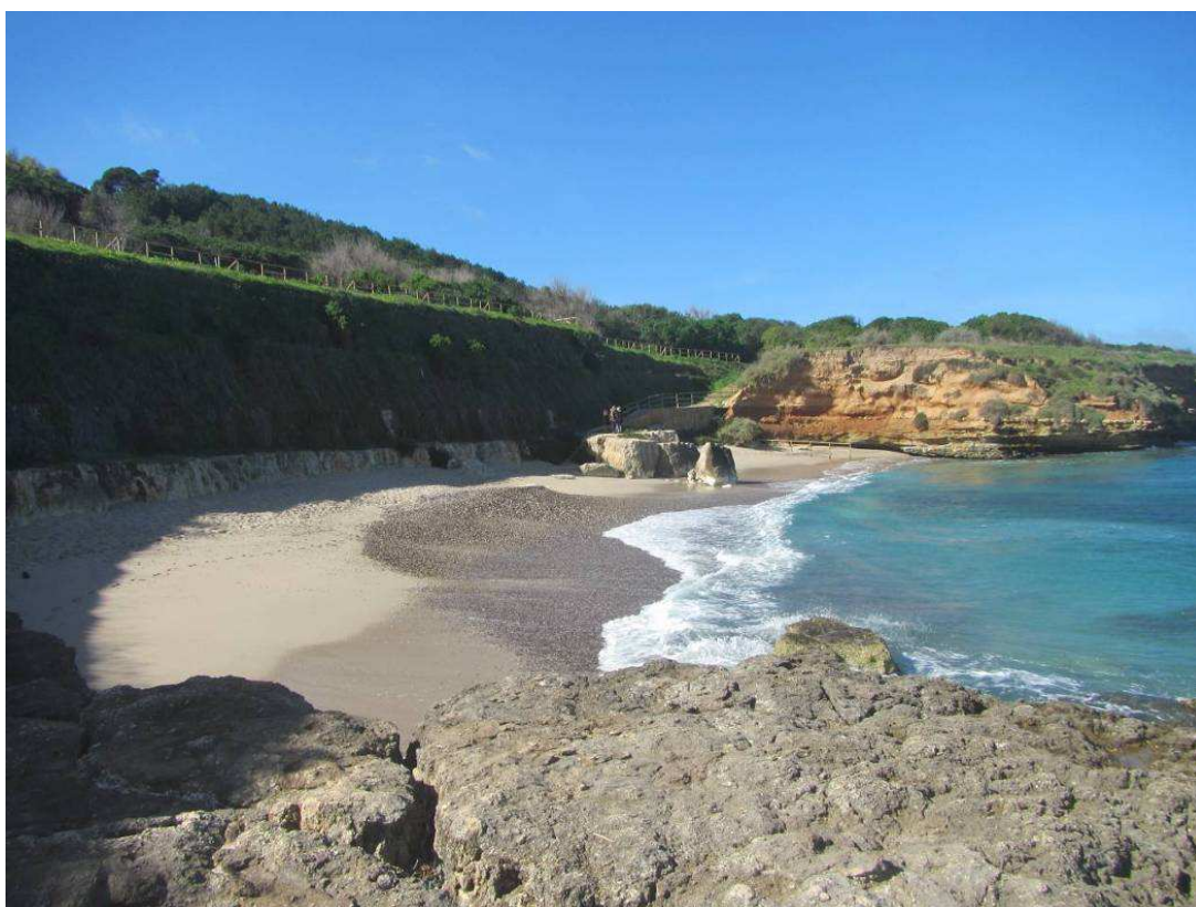
Figura 20. Porzione ovest della spiaggia di Farrizza. Si noti il tratto di promontorio roccioso con falesia attiva e, a sinistra, la scarpata stabilizzata con interventi del tipo "terre rinforzate"
