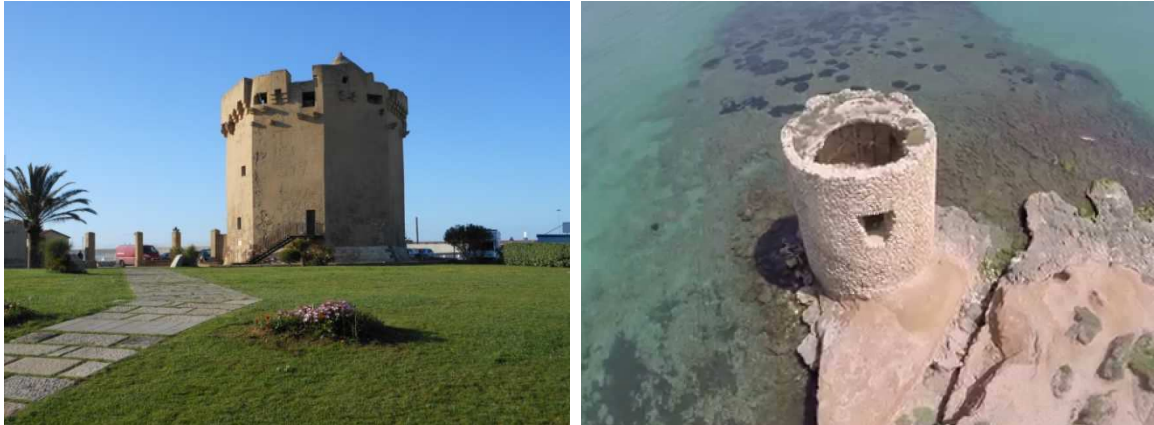
Figura 33. Torre del Porto e Torre di Abbacurrente
