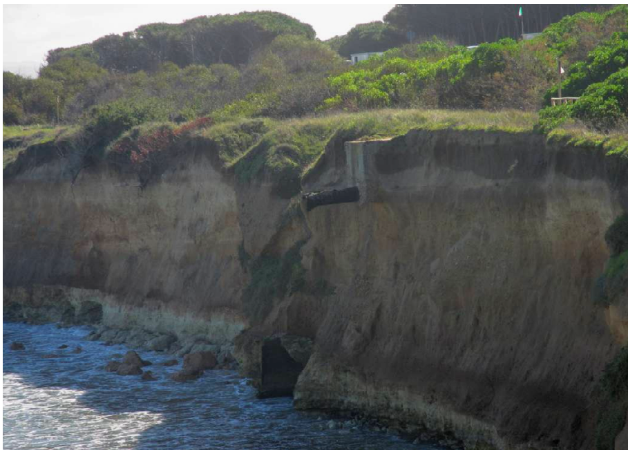
Figura 16. Particolare di un tratto di falesia in rapida evoluzione con movimenti franosi attivi
