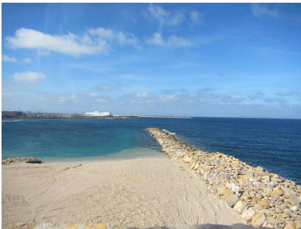
Figura 15. Il pennello artificiale e il deposito sabbioso derivante dal ripascimento con inerti da cava.
