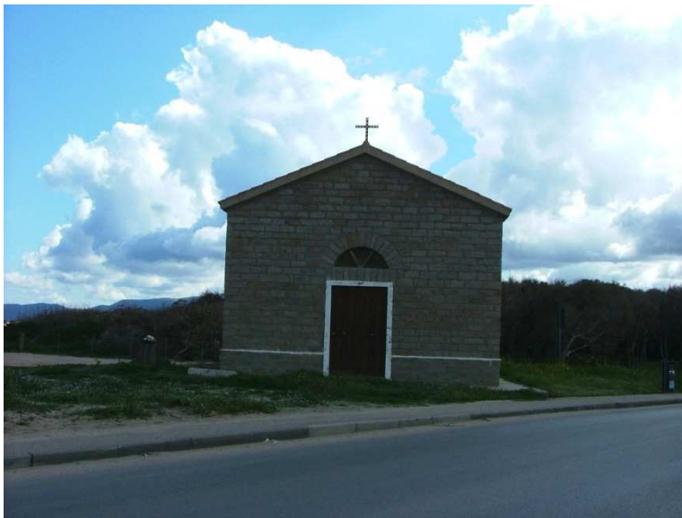
N°5. Veduta da sud-ovest della facciata della chiesa.
