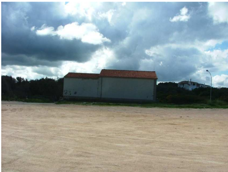
N°8. Veduta da nord del lato settentrionale della chiesa.
