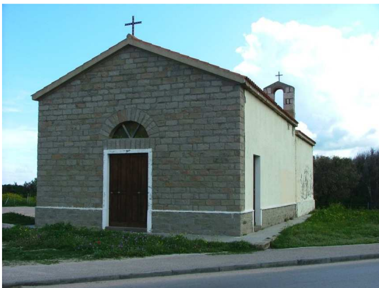
N°6. Veduta da sud-ovest della facciata e del lato meridionale della chiesa.
