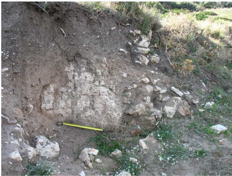
N°15. Veduta da nord-ovest delle strutture murarie affioranti lungo le alte sponde del fiume Coghinas.
