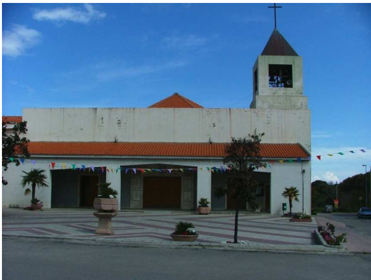
N°5. Veduta da nord della facciata della chiesa.
