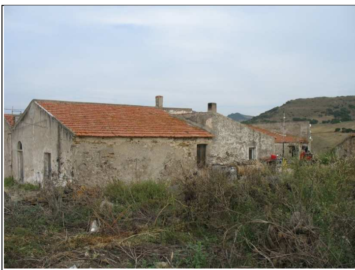
N°12. Veduta da nord-ovest del terzo blocco di edifici.
