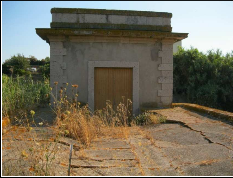
N°6. Veduta da nord-est della facciata dell'edificio.
