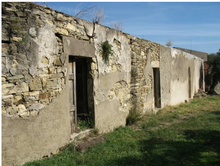
N°7. Veduta da sud del primo blocco di edifici.
