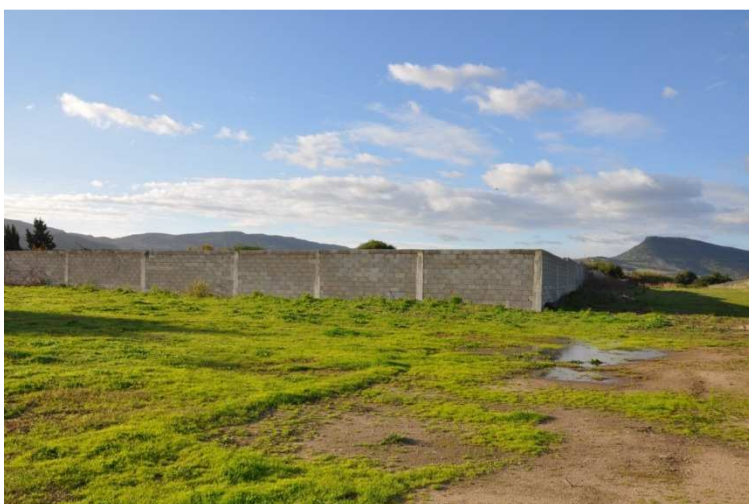
N°7. Veduta del lato settentrionale da nord-est.
