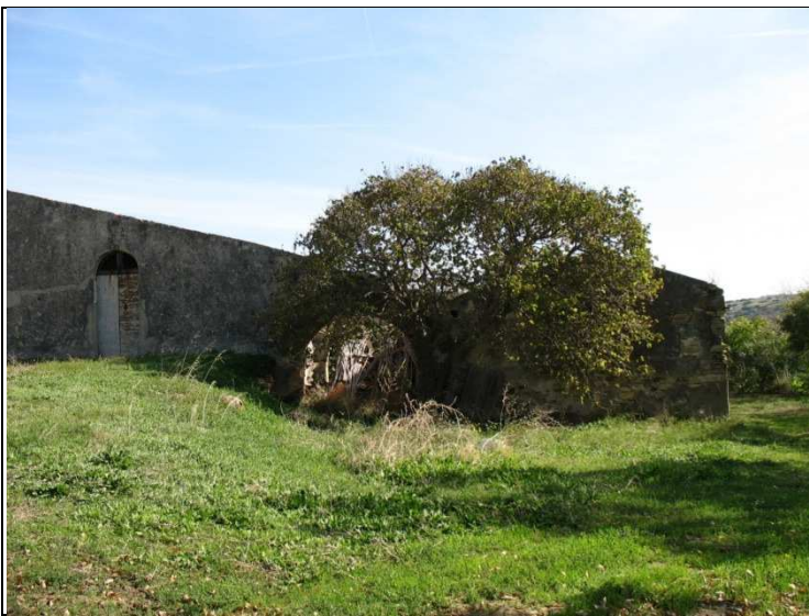
N°6. Veduta da ovest del primo blocco di edifici.
