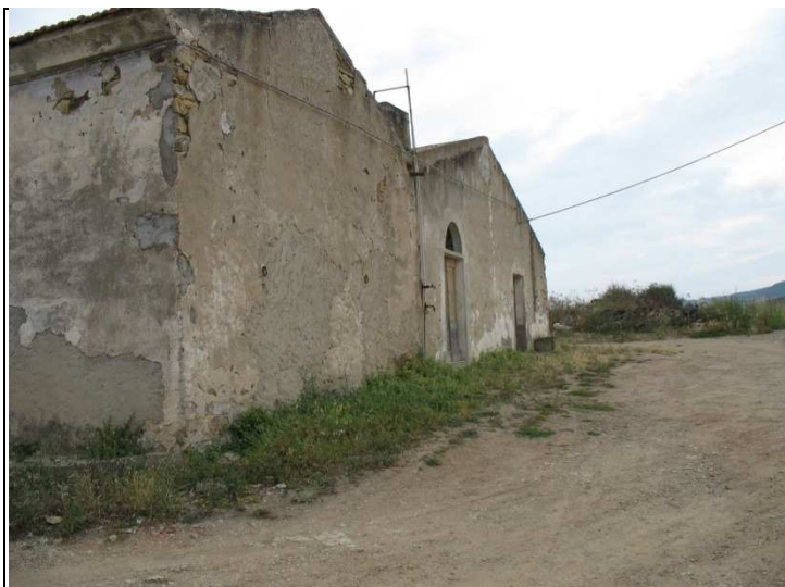
N°11. Veduta da nord-est del terzo blocco di edifici.
