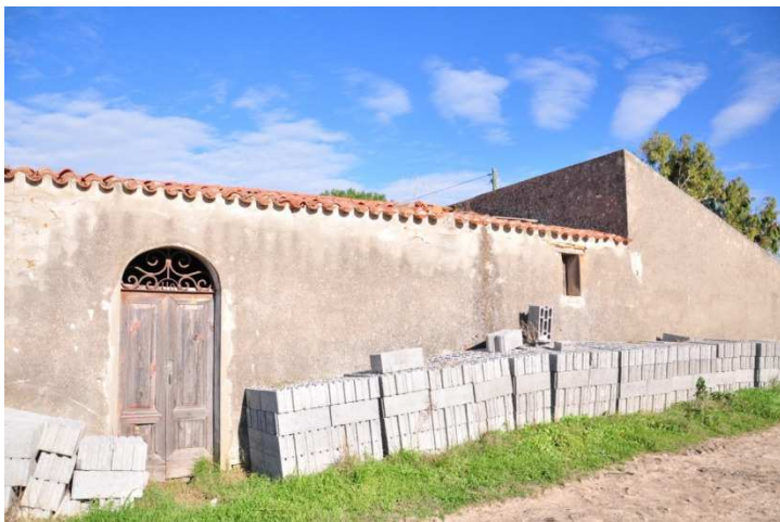
N°6. Veduta da sud del lato meridionale dello stazzo.
