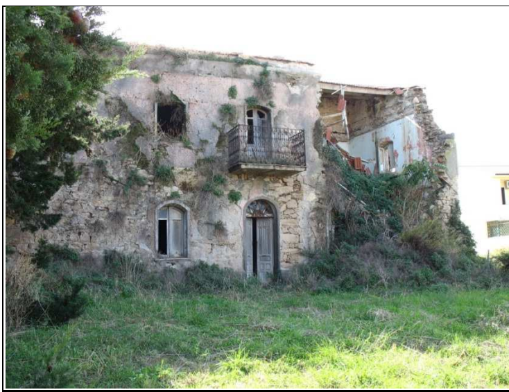
N°6. Veduta da nord-est della facciata dell'edificio.
