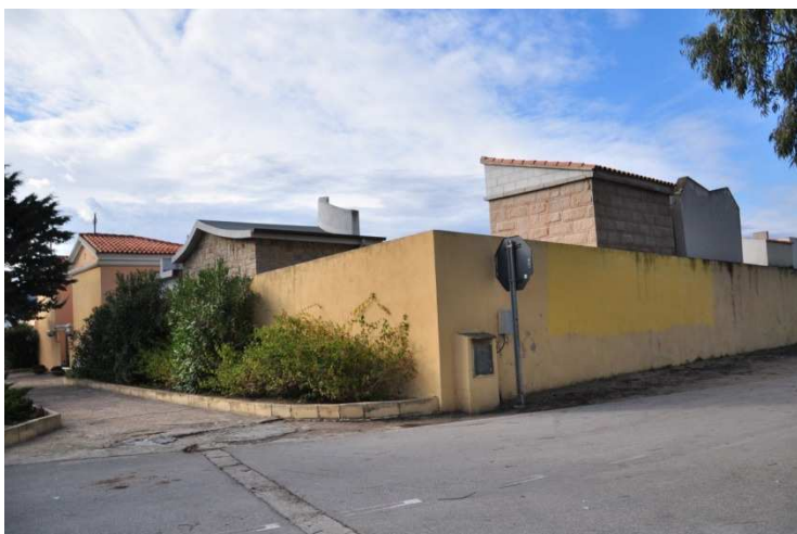
N°6. Veduta del lato orientale da sud-est.
