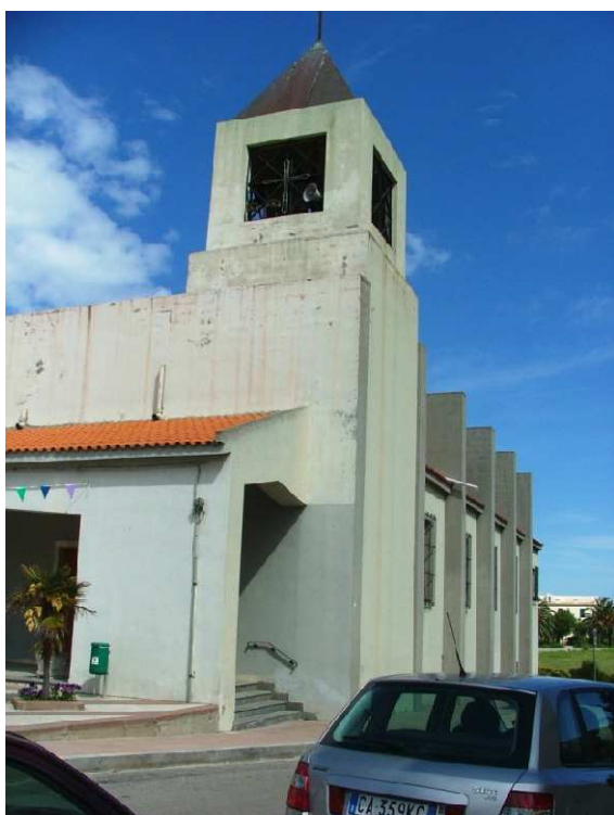
N°6. Veduta da nord-ovest del campanile e del lato occidentale.
