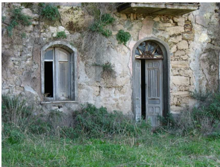
N°8. Particolare del portone d'ingresso dell'edificio.
