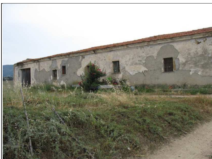
N°10. Veduta da nord-est del terzo blocco di edifici.
