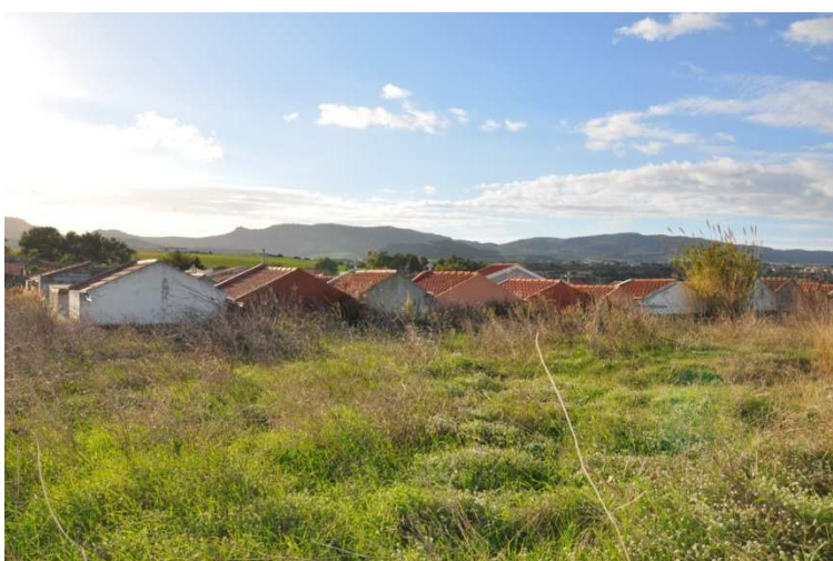
N°8. Veduta del lato settentrionale da nord.
